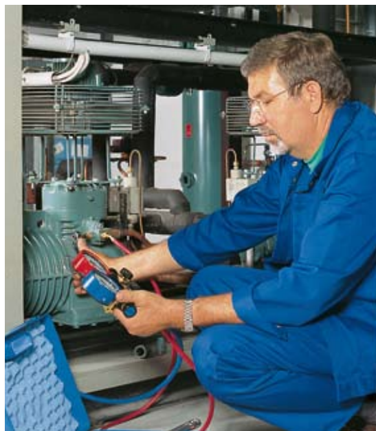
Die Tiefkühlung dieses Supermarktes wurde schon sehr früh und bis heute erfolgreich von R-22 auf R-407A umgestellt. Für die gleichzeitige Neuinstallation der Normalkühlung fiel die Entscheidung auf R-134a.
