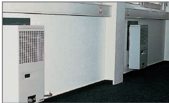
Zuverlässige Bürocontainer-Beheizung mit Außenwand-Raumheizern.
